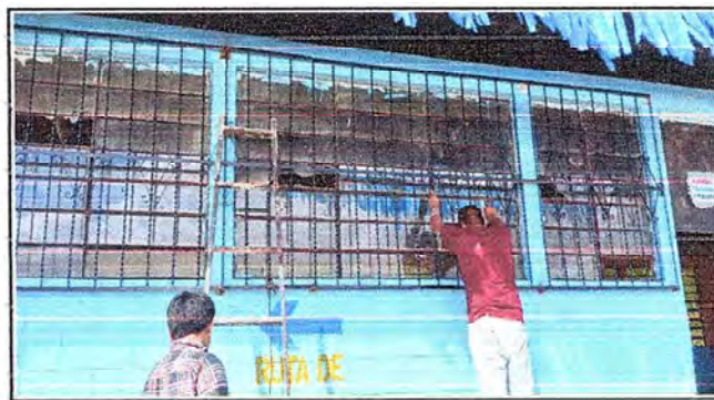
Foto 4: SUSTITUCIÓN DE BALCONES DE AULAS
