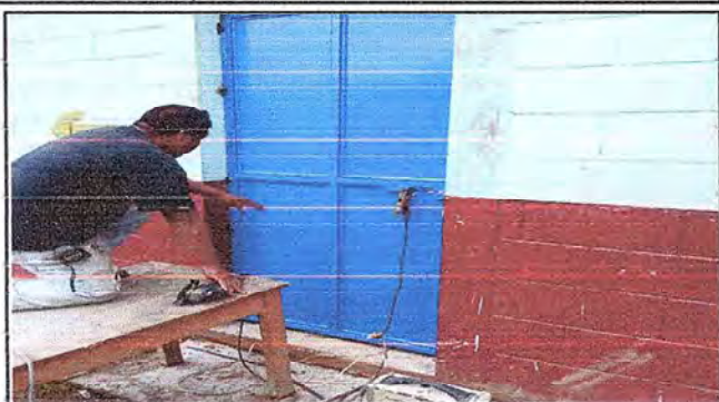
Foto1: SUSTITUCION DE PUERTAS
