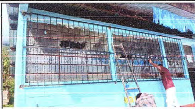
Foto 2: SUSTITUCION DE BALCONES
